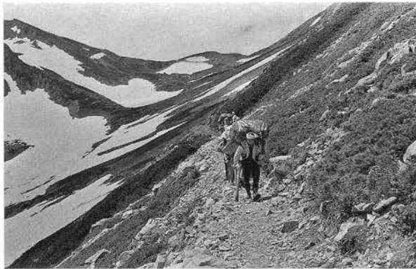
大町トンネル開通までの資材輸送は、ボツカによる立山越えが唯一の手段であった。
