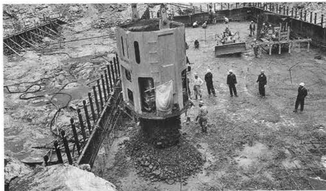
コンクリート・バケットによるコンクリートの流し込み
