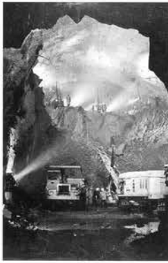
発電所内部掘削作業
