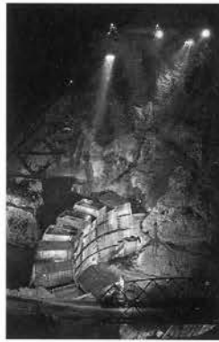
夜を徹しての建設作業
