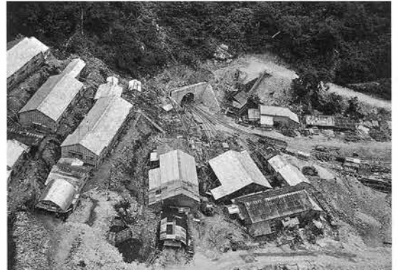
昭和31年、大町トンネルの掘削始まる
