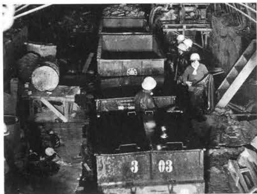
大量の排土をトロツコを使って搬出する
