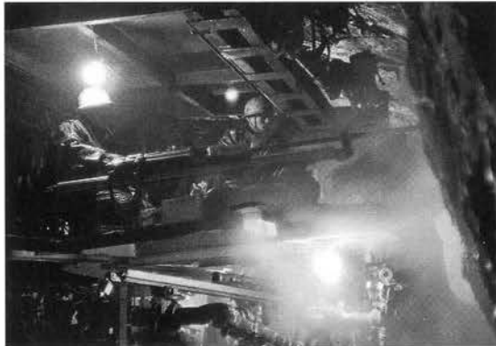
大町トンネルの本坑掘削風景 大型掘削機「ジャンボ」
