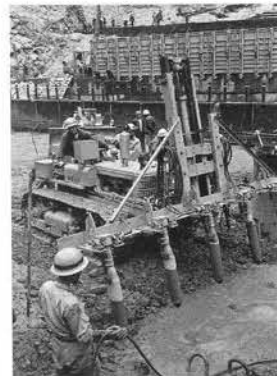
大型重機による コンクリートの打ち込み風景
