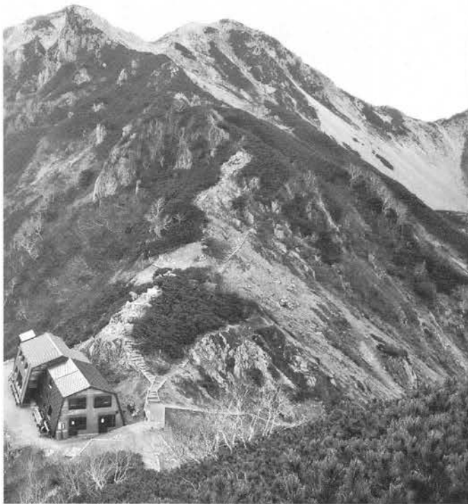
現在の針ノ木小屋全景
