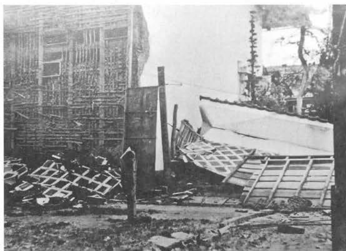
写真2 1918年(大正7年)11月発生の大町地震で倒壊した家屋
