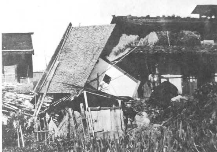
写真1 1918年(大正7年)11月発生の大町地震で倒壊した家屋
