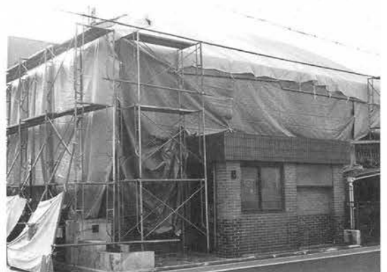
写真2 修復中の旧山崎歯科医院 この後、取り壊しが決まった。
