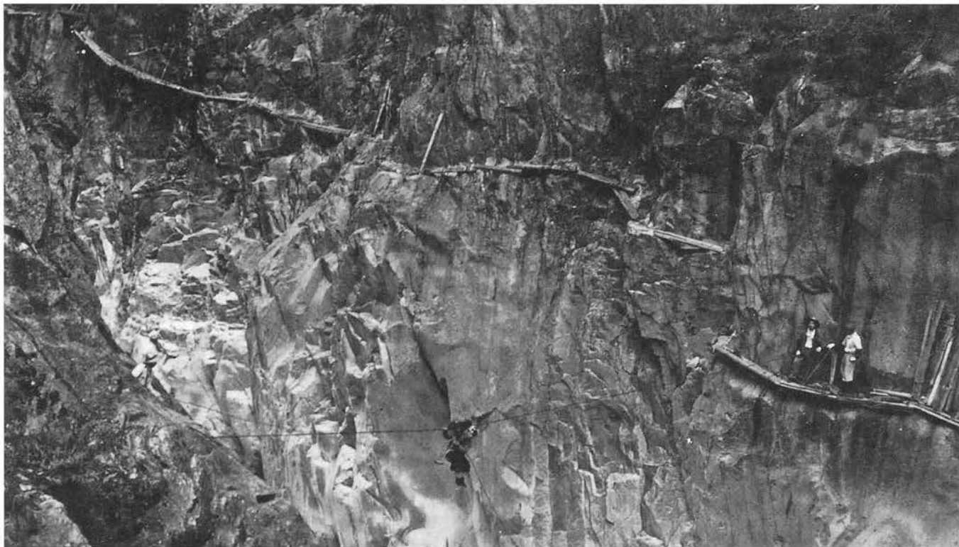
写真1 黒部峡谷「下の廊下」 旧日電歩道 吊栈道と測量のための吊越し 撮影年代不詳（昭和31年頃か） （写真は表紙・本文とも関西電力（株）所蔵）
