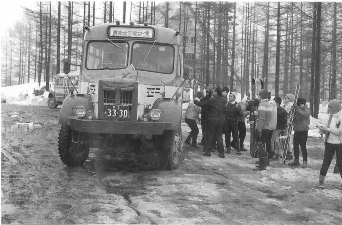
松本電鉄が、積雪悪路の坂道で、スキー客を輸送するために導入した四輪駆動バス。当時は、列車でスキー場近くの駅まで行き、バスに乗り換えた。(昭和46年2月、鹿島槍国際スキー場)
