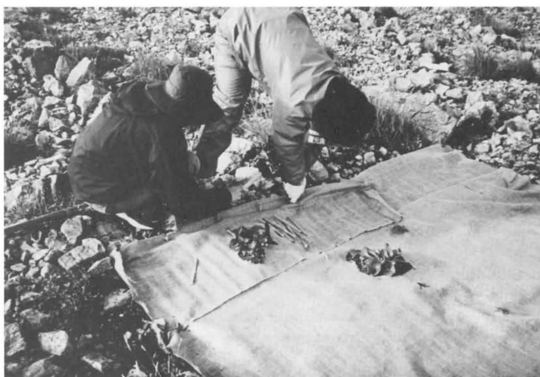
ジュート製ネットによる工法で復元をはかる(白馬山荘下)
