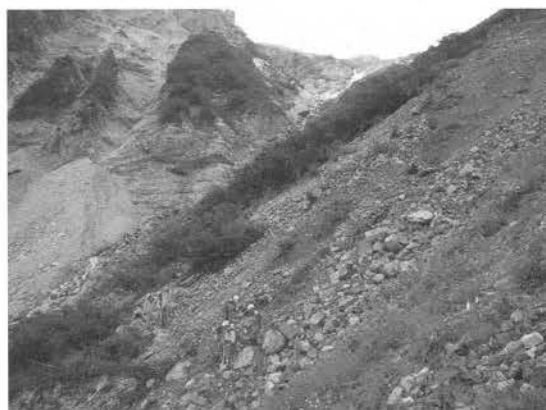
激しい雨の後の秋道の地滑り性崩落跡
