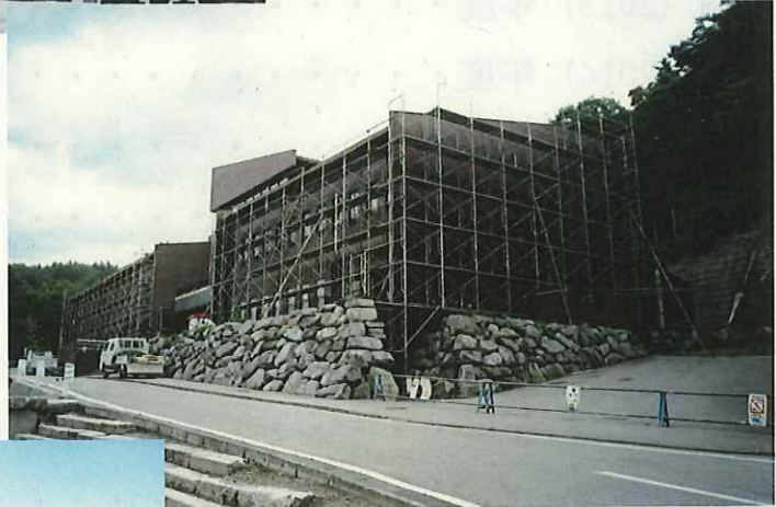
3代目博物館外壁改修工事
