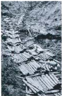
1-11 写真「シユラによる木材の搬出」複製 松本市安曇資料館蔵(奥原貞夫氏提供)
